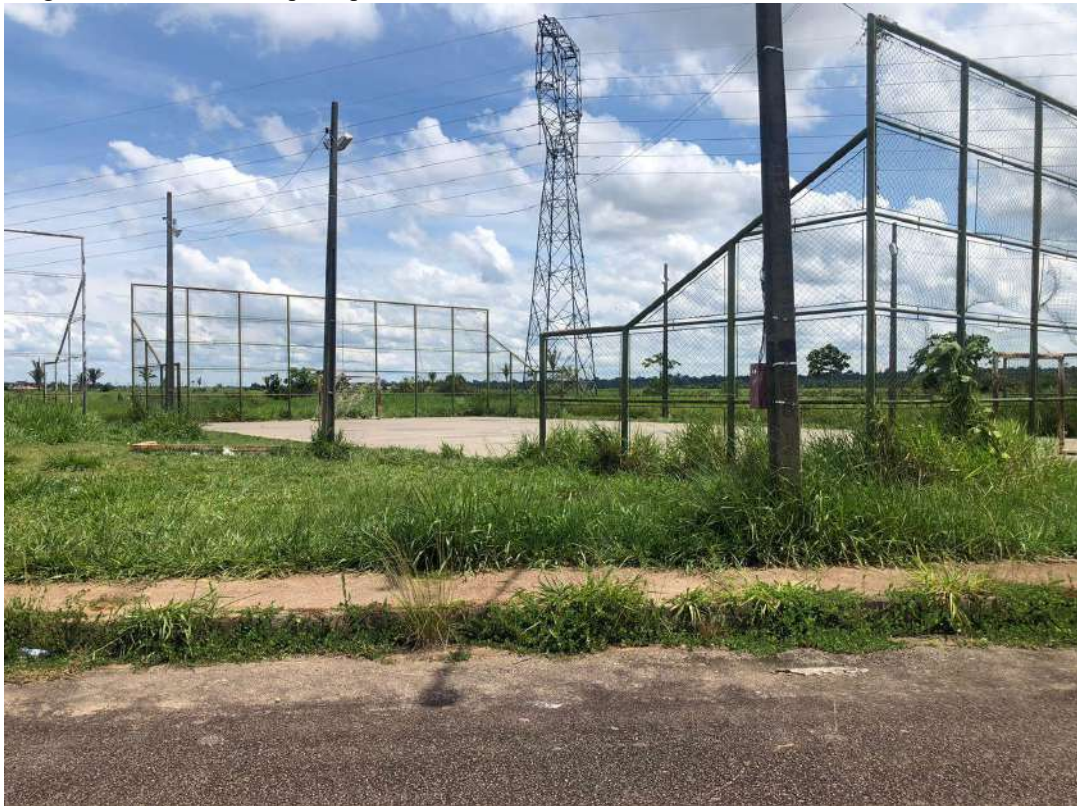
Figura 14 - Quadra de Esporte próxima à torre da Linha de Transmissão em Nova Mutum Paraná
