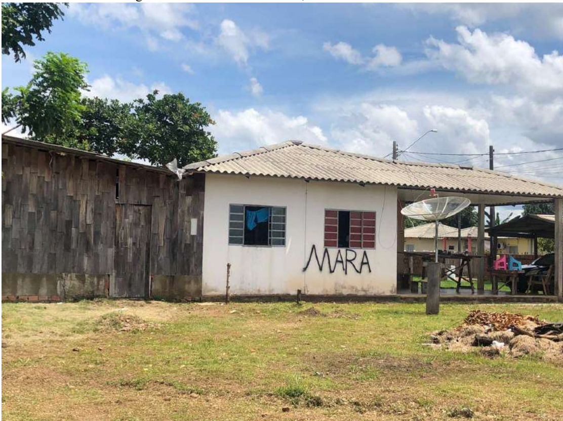
Figura 10 - Casa de reassentados, extensão da casa feita de madeira
